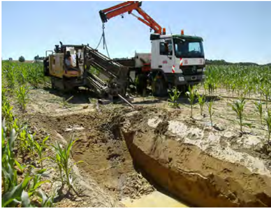
Spülbohrung unter der A94
