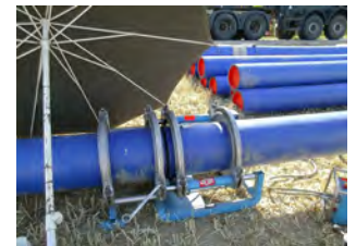
Spiegelschweißen PE-Schutzrohr
