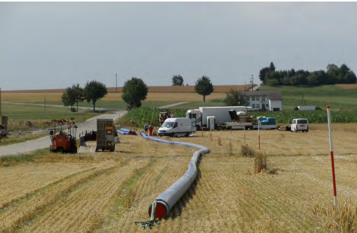
Spiegelschweißen PE-Schutzrohr
