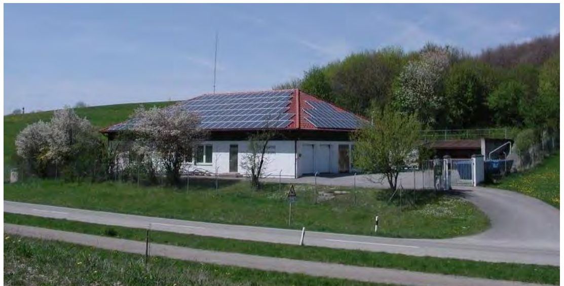
Büro, Verwaltung und Hauptpumpwerk
