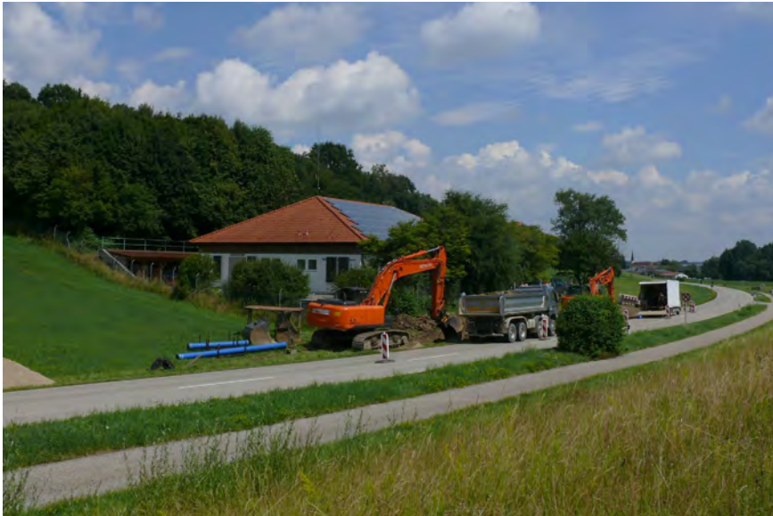
Beginn der Arbeiten am Hauptpumpwerk Schwindegg
